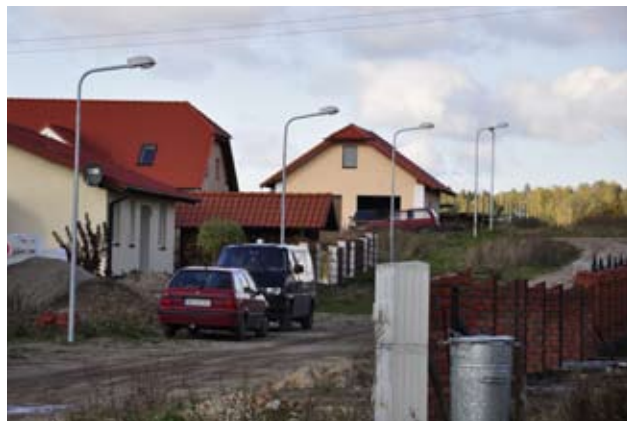
Nowe oświetlenie uliczne na osiedlu Leśnym w Jonkowie
